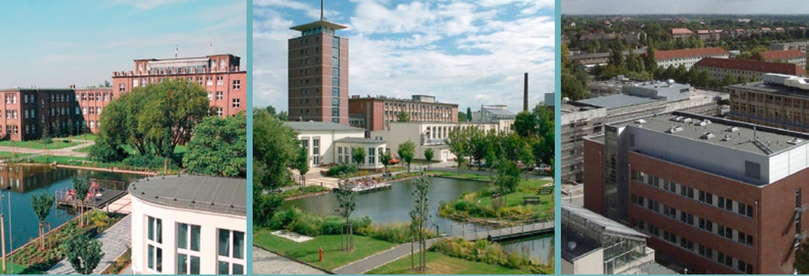
Stein gewordene Geschichte: Die Gebäude im Leipziger Wissenschaftspark an der Permoserstraße entstammen unterschiedlichsten Zeiten.
