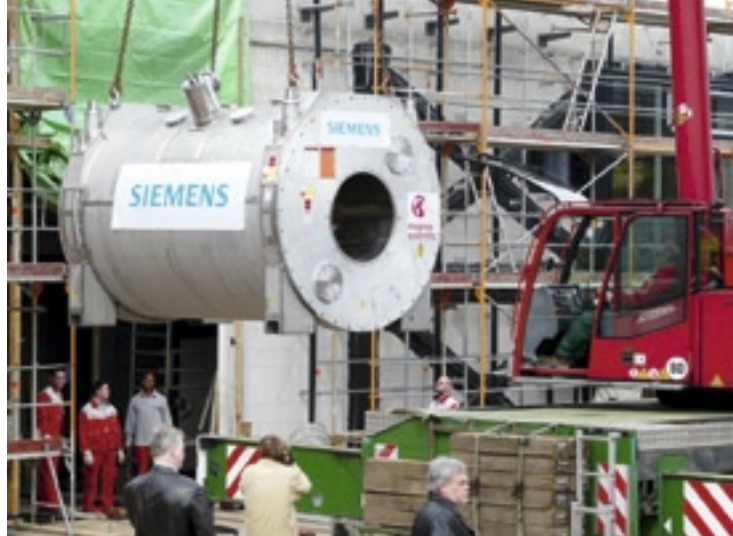
Anlieferung des Magneten: Die 32 Tonnen Gewicht konnte nur ein spezieller Kran heben.
